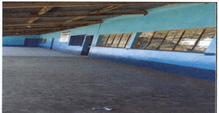
Foto 6: Cambio de balcones
